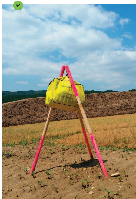
Exemple d'un kit anti-pollution isolé du sol.
