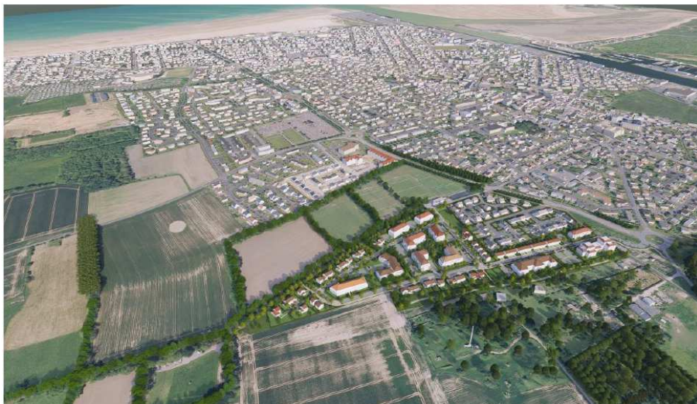
Insertion du projet dans son environnement (A26 BLM)
