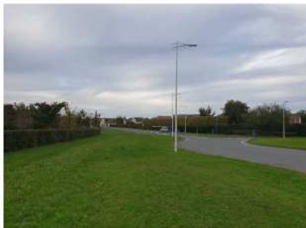
Vue sur le futur accès au quartier depuis le giratoire
