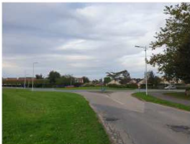
Vue sur le giratoire existant
