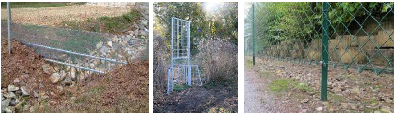
Exemples de dispositifs de perméabilité des clôtures
