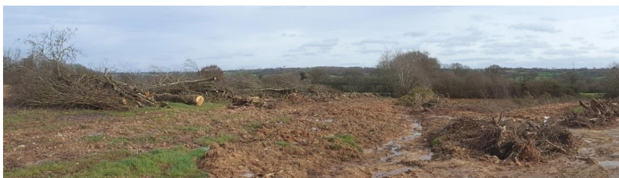
Défrichement de haies à Amigny (50) 2020 dans le cadre d'un projet de carrière
