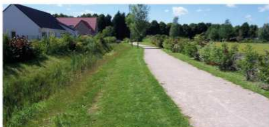
Image de ref : chemin bordé d'une noue
