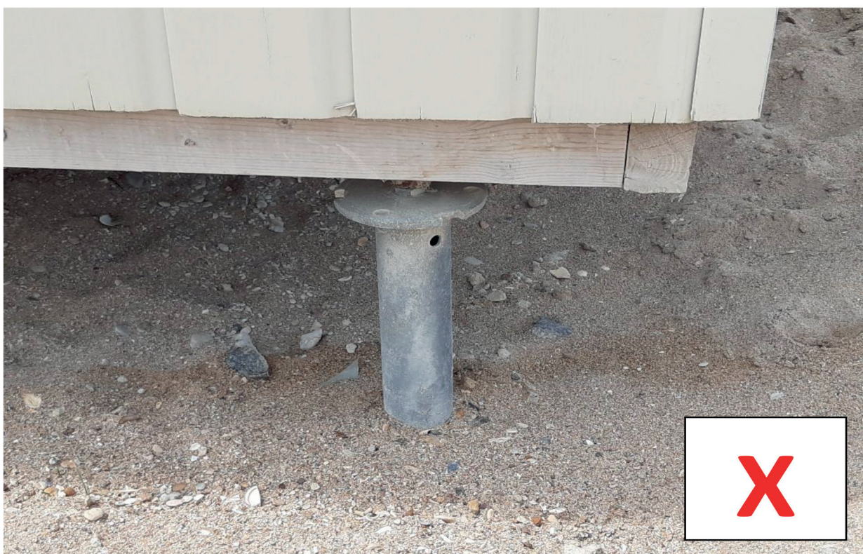
Fondation non conforme
