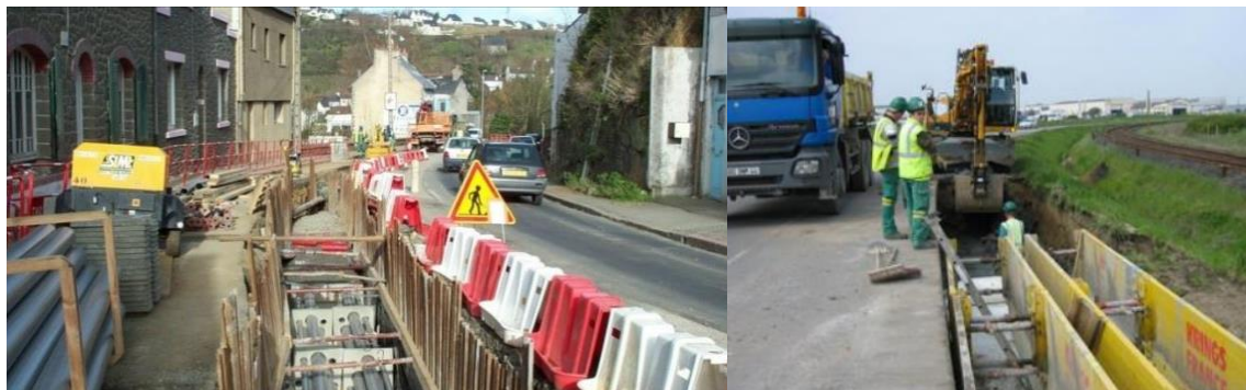
Figure 4 : Pose de liaison souterraine PVC béton à deux circuits sous et en bordure de voie. Source RTE.
