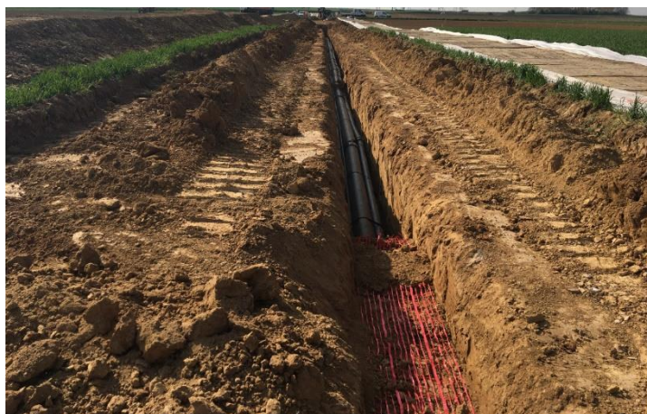
Figure 5 : Pose d'une liaison souterraine 225 kV en fourreaux PEHD en zone agricole. Source : RTE.
