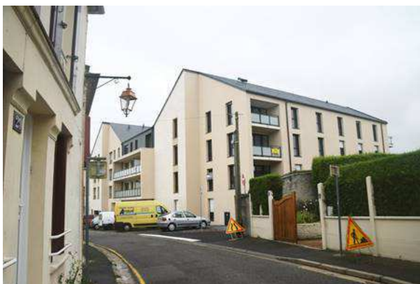
Photo du chantier en juillet 2017
