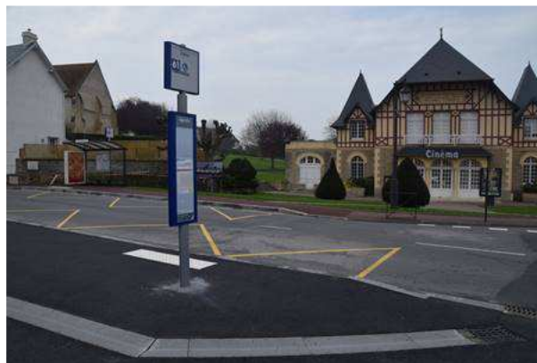
Nouveau quai de plain-pied, avenue Michel-Cabieu
