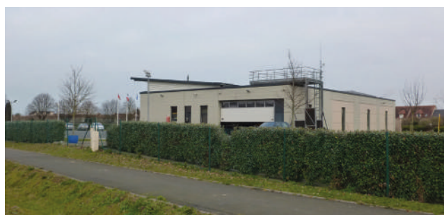
CENTRE D'INCENDIE ET DE SECOURS
