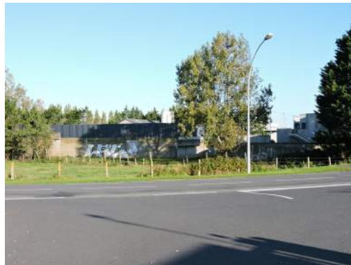
Photo 46: Vue de la station d'épuration de Ouistreham
