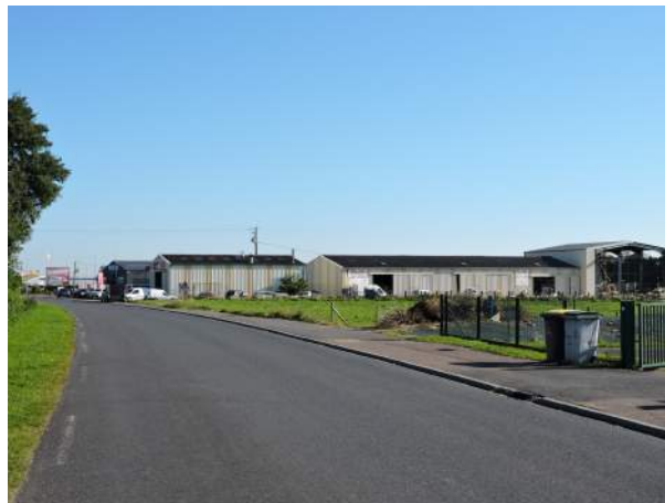
Photo 45: Hangars de la zone d'activités
